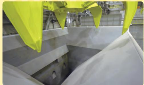
ごみピットでよく混ぜられたごみを、クレーンで投入ホッパに入れます。投入ホッパから焼却炉へ少しずつごみを投入することで、安定して燃やすことができます。
