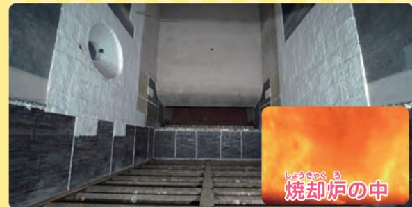
焼却炉では、850度以上の高温でごみを完全燃焼させて、有害物質の発生を抑えています。ごみを燃やした後に排出する排ガスも、有害物質を取り除く装置を通ってきれいになります。
