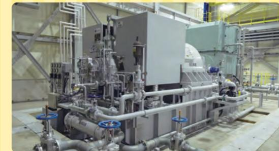
ごみを燃やした熱で水を蒸気に変え、蒸気でタービンを回転させて電気をつくります。つくった電気は施設内で利用し、余った電気は小学校などに送っています。
