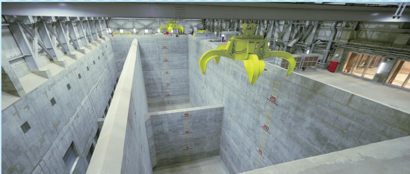
**쓰레기 피트** 수집 피트에 투입된 쓰레기를 쓰레기 크레인을 사용해 교반 피트로 옮긴 후 쓰레기가 잘 타도록 교반합니다. 쓰레기 피트의 용량은 26,000m<sup>3</sup>(25m 수영장 약 50개 분량)입니다.
