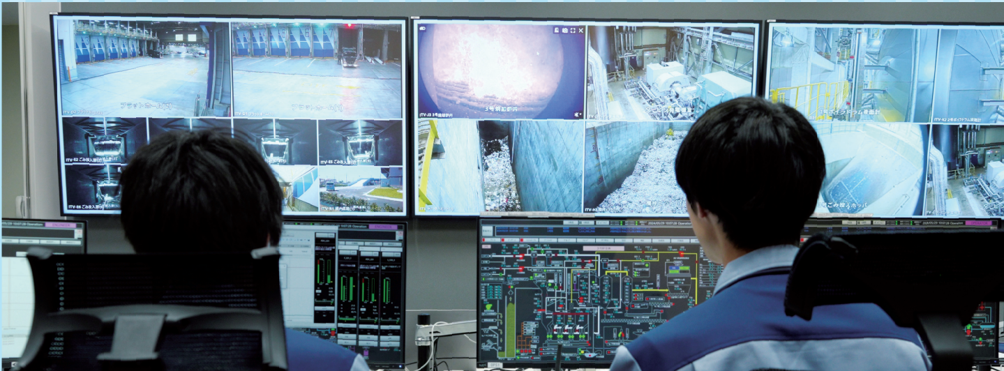
Central control room Dito sinusubaybayan ang katayuan o status ng pagpapatakbo ng buong pasilidad (temperatura sa loob ng incinerator, konsentrasyon ng mga mapanganib na kemikal sa exhaust gas, atbp.) at pinatatakbo ang mga kagamitan. Gumagamit din dito ng remote monitoring and remote operation mula sa labas ng pasilidad para magsagawa ng ligtas, panatag at patuloy na pagpoproseso ng mga basura.
