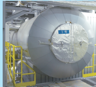
Boiler Ang init mula sa exhaust gas na nabubuo sa pamamagitan ng pagsusunog ng basura ay ginagamit upang makabuo ng mataas na temperatura at mataas na presyon na singaw, na pagkatapos ay ipinapadala sa isang turbine.
