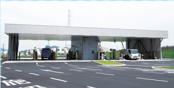
Timbangan ng Truck Sinusukat ang bigat ng bawat sasakyan gamit ang timbangan ng trak para makuha ang kabuuang dami ng basurang dinala.
