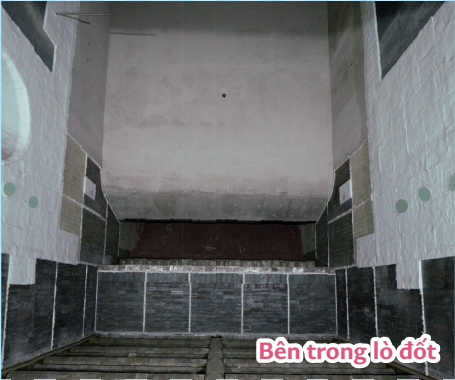
Lò đốt Lò đốt đốt cháy rác hoàn toàn nhờ công nghệ điều khiển đốt tự động. Đốt ở nhiệt độ cao từ 850°C trở lên giúp ngăn chặn sinh ra các chất có hại như dioxin, v.v. Công nghệ đốt không khí ở nhiệt độ cao cho phép đốt cháy ổn định chỉ với một lượng nhỏ không khí.
