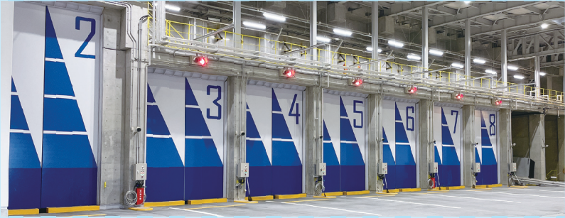
Sàn tập kết rác Sau khi cân rác, xe chở rác sẽ đổ rác vào hố qua 8 cửa nạp. Cửa nạp hai lớp và có kiểm soát áp suất không khí để ngăn mùi rác thải thoát ra ngoài.
