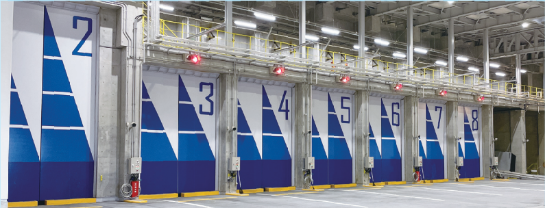
Plataforma Una vez pesados los camiones de basura, vierten su contenido en la fosa de residuos a través de una de las ocho compuertas de carga. Se emplea un sistema de doble compuerta y una presión de aire controlada para evitar que se filtren los olores.
