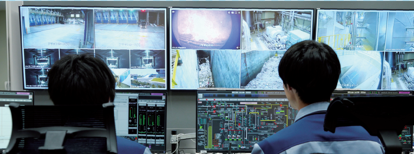
Sala de control central Desde esta sala se supervisa el estado operativo de toda la instalación (incluida la temperatura en el interior del incinerador y la concentración de sustancias nocivas en los gases de escape) y se manejan los equipos a distancia. También se utiliza la supervisión y el manejo a distancia desde el exterior de la instalación para garantizar un tratamiento seguro y estable de los residuos.
