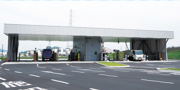
Báscula para camiones Cada vehículo se pesa en una báscula de camiones para totalizar la cantidad de residuos recogidos.
