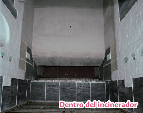
Incinerador La combustión en el incinerador se controla automáticamente para quemar completamente los residuos. La combustión se lleva a cabo a temperaturas superiores a los 850°C para reducir la producción de sustancias dañinas, incluyendo dioxinas. La tecnología de combustión de aire a alta temperatura permite una combustión estable utilizando menos aire para una mayor eficiencia energética.
