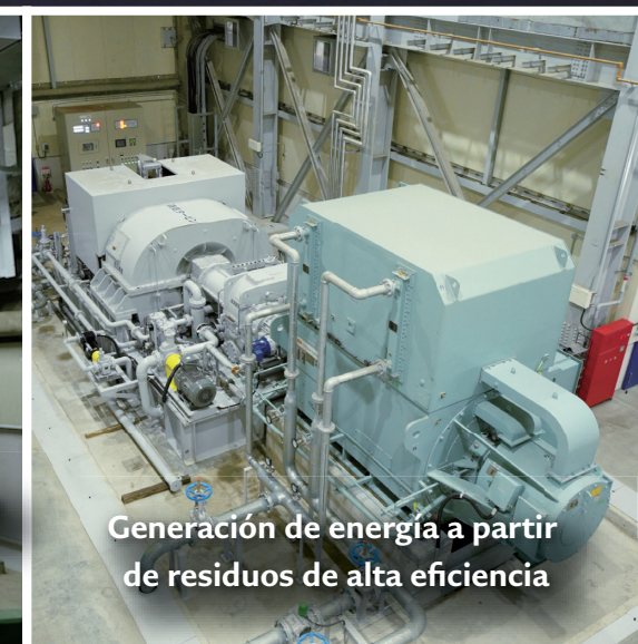
El generador de emergencia permite el funcionamiento autónomo incluso en caso de catástrofe
