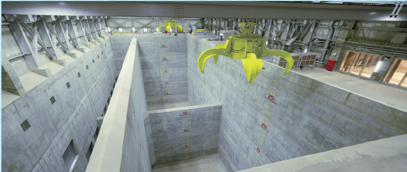
**垃圾貯坑** 投入收料貯坑中的垃圾透過垃圾吊車移至攪拌貯坑，進行攪拌以便垃圾充分燃燒。垃圾貯坑的容量為26,000m<sup>3</sup>（約50個25m游泳池的大小）。
