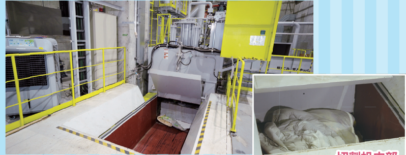
立式切割机 用强有力的切刀，将榻榻米、被子等较软的可燃大件垃圾切割成一定的长度。
