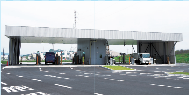
称重机 称重机对整个车辆进行称重，对垃圾搬入量进行汇总。
