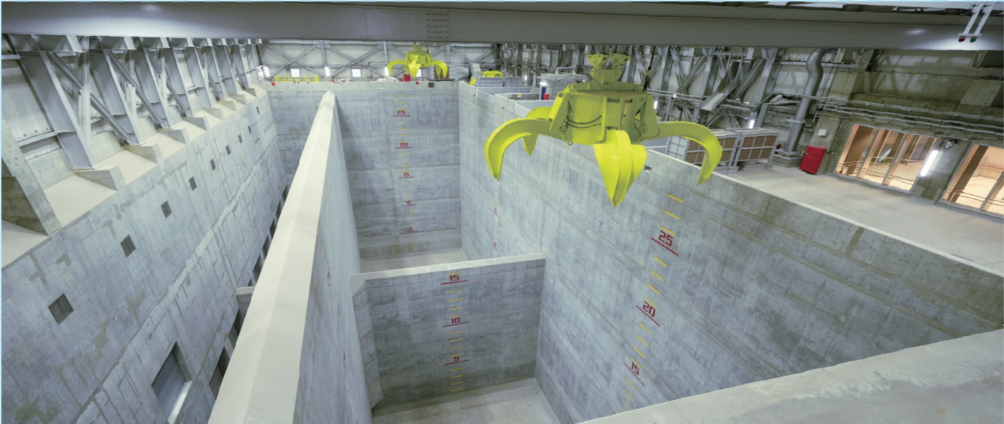
垃圾坑 投入收料坑中的垃圾通过垃圾抓斗吊车移至搅拌坑，进行搅拌以便垃圾充分燃烧。垃圾坑的容量为26,000m³（约50个25m泳池的大小）。
