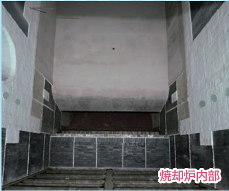
焼却炉 焼却炉では、自動燃焼制御によりごみを完全燃焼させます。850℃以上の高温で燃焼を行うことにより、ダイオキシン類などの有害物質の発生を抑制します。高温空気燃焼技術により、少ない空気量で安定した燃焼を行うことができます。
