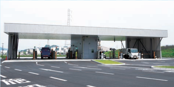
計量機 計量機で車両ごと重さを計り、ごみの搬入量を集計します。
