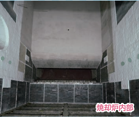
焼却炉 焼却炉では、自動燃焼制御によりごみを完全燃焼させます。850℃以上の高温で燃焼を行うことにより、ダイオキシン類などの有害物質の発生を抑制します。高温空気燃焼技術により、少ない空気量で安定した燃焼を行うことができます。
